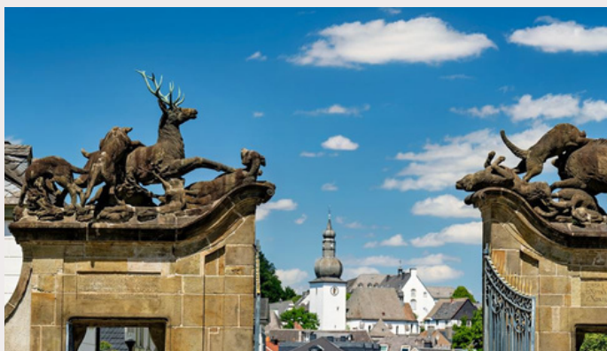
Das Hirschberger Tor vor der Restaurierung.
